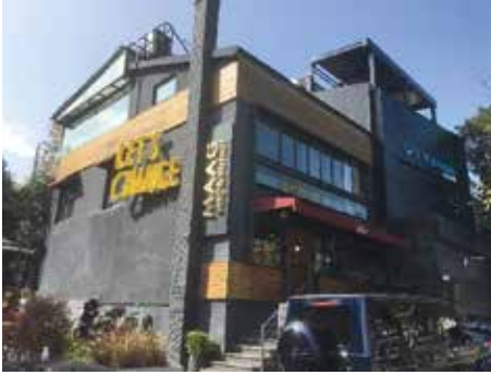
Resim 4-6. Etiler Yapı Kooperatifi.
