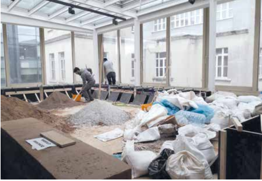
Şekil 11. SALT Kış Bahçesi, yapım aşaması.
