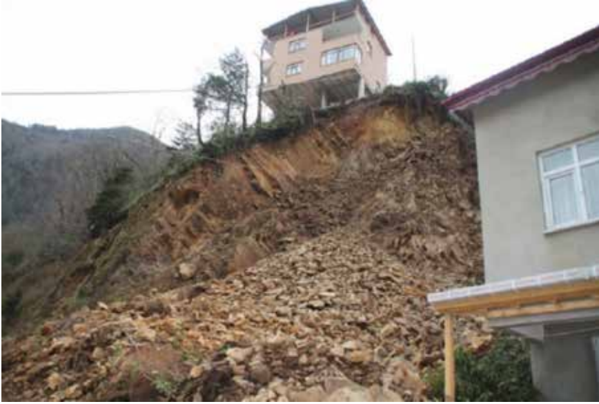
Şekil 3. Hatalı yerleşim kararı nedeniyle heyelandan etkilenen bir yapı.
